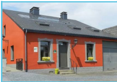
La Fermette - Vue de la façade avant
